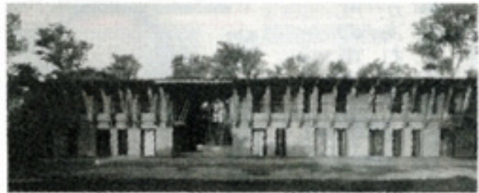
[2] 大小の竹と土のみでつくった2階建ての「竹筋校舎」
