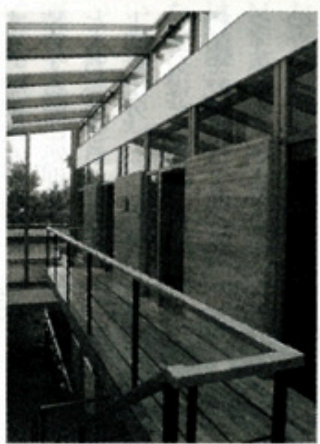
[4] 土をつき固める版築工法で建てられた印刷工場
