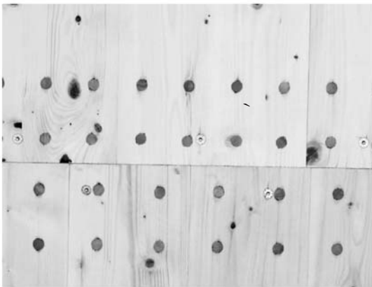
壁パネル2枚の水平ジョイント
