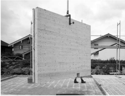
壁パネルをクレーンで移動させ枕材に設置する
