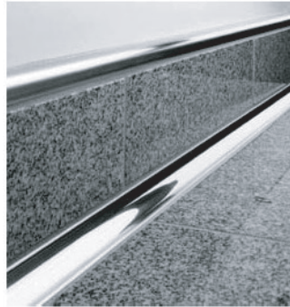
図20：溝型ステンレス型材 床・壁面との接続部目地にシリコンを使わない 出典：Schlüter社 www.schlueter.de
