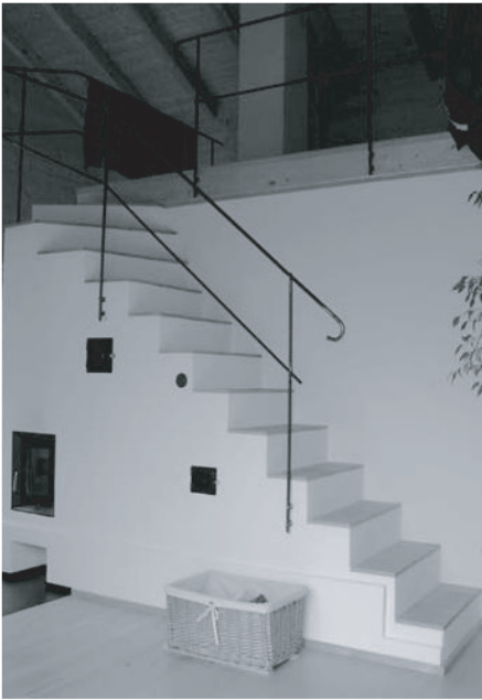
図9a 温水・熱交換を組み込んだストーブ 建物全体を暖め、同時階段の機能をもつ
