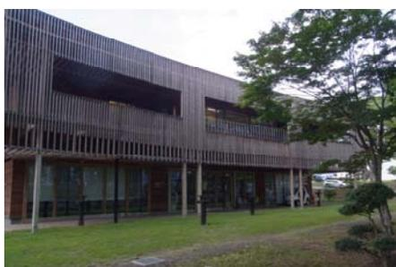
大断面集成材を使わず、無垢の木材だけで造られていることに圧倒されます。このような大きな施設でも構造に無垢の木材が使えるということに感動しました。構造は、山田憲明氏。その他の建材も極力自然素材に近いものを選択し、環境と健康に配慮された建物です。
