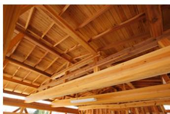
落とし板工法で施工された、工務店社長のご自宅兼、モデルハウス。
